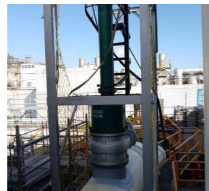
科技廠 28" 冷卻水管施工
