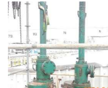
石化廠 6" 蒸氣管施工
