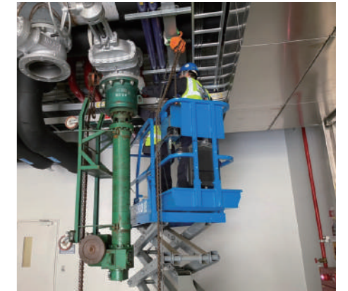
科技廠 14" 冰水管施工
