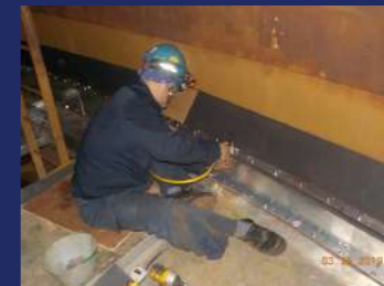
二次刮板安裝作業
