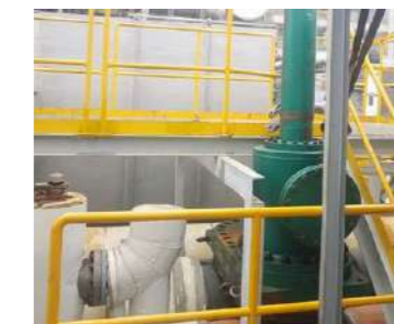
科技廠 16" 蒸氣管施工
