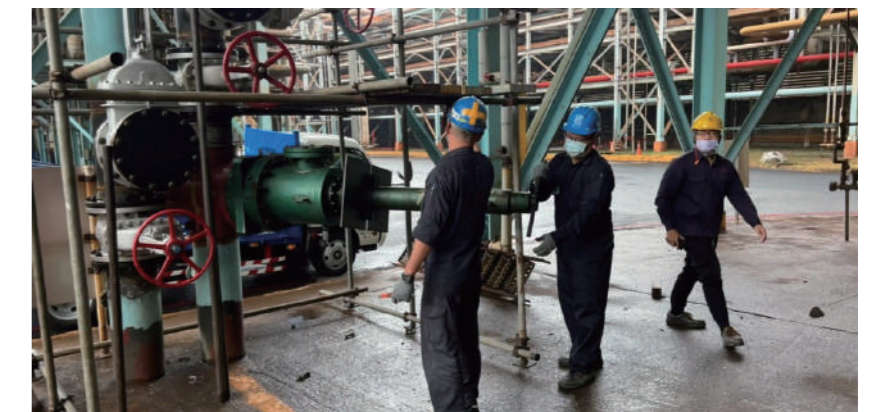
煉油廠冷卻水阻斷施工
