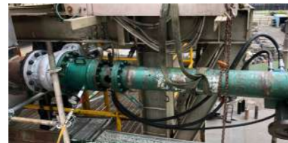
鋼鐵廠 10" 廢氣管施工
