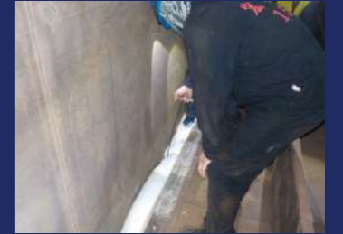
P U 發泡海綿安裝作業
