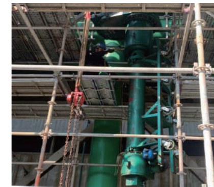
鋼鐵廠 20" 蒸汽管施工
