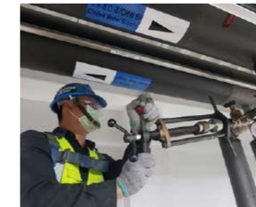
科技廠 2" 冰水管施工
