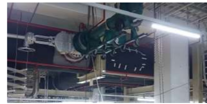
科技廠 22" 冰水管施工
