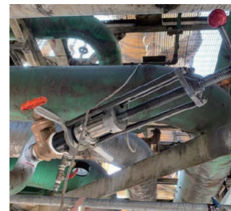
鋼鐵廠 3" 冷卻水管施工
