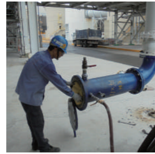
石化廠 12" 甲醇管線施工
