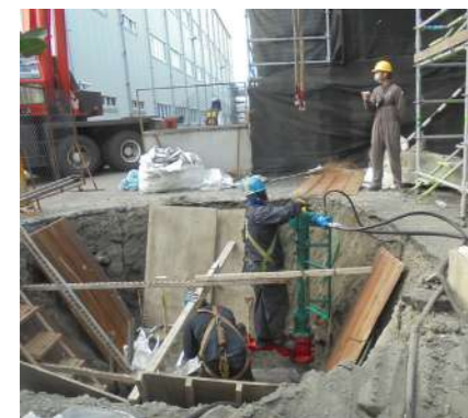
石化廠 6" 地下消防管施工
