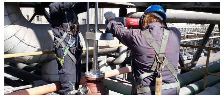
鋼鐵廠 8" 冷卻水管施工
