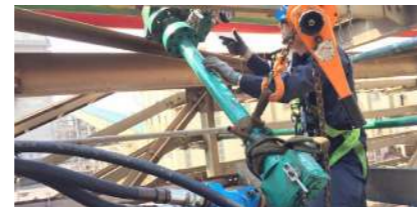
鋼鐵廠 3" 蒸氣管施工
