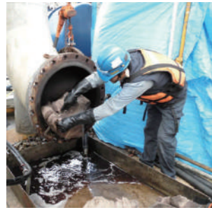
石化廠 24" 柴油管線施工
