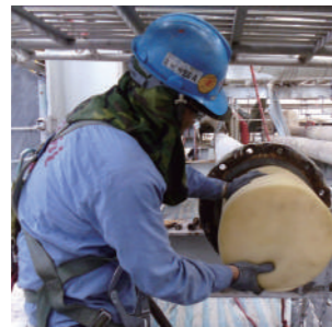
石化廠 10" 製程管線施工
