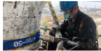
石化廠 2" 夾管開孔施工
