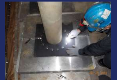
立管密封墊片安裝作業
