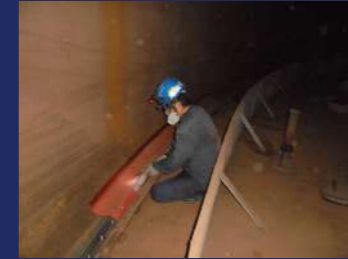
舊料移除作業
