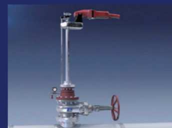
4. 開孔機具安裝作業
