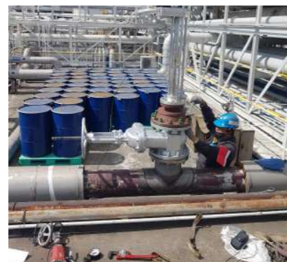
石化廠 10" 油管施工
