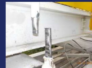
3. 舊管切管移除
