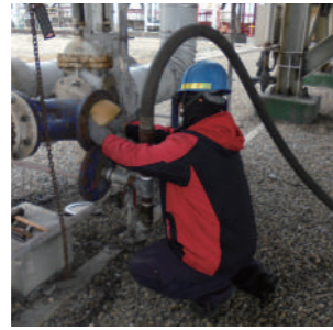
石化廠 8" 新配管線施工
