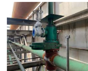
鋼鐵廠 10" 冷卻水管施工
