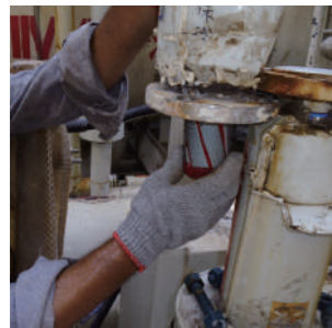
石化廠 2" 製程管線施工
