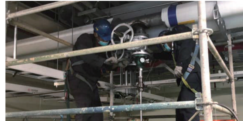
科技廠 6" 冰水管施工
