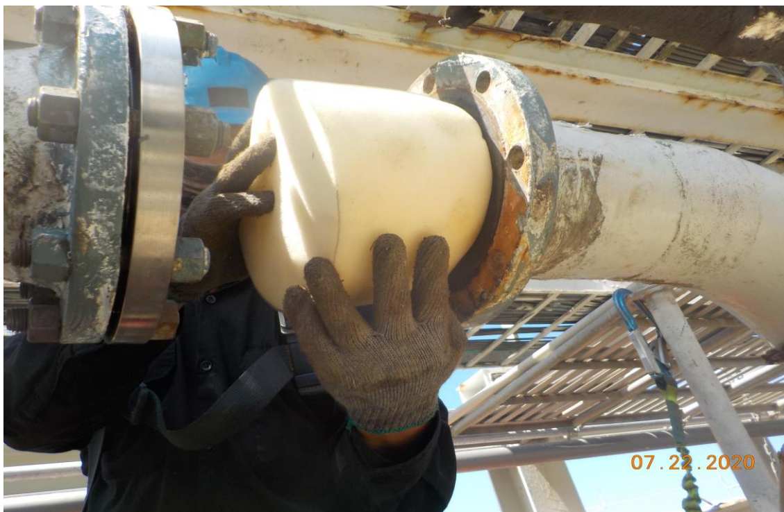
PIG 海綿安裝情況(4)
