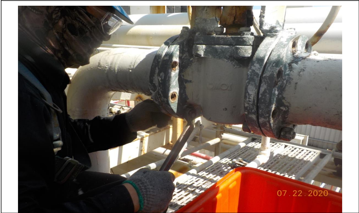
發射端安裝前移除閥件情況(2)
