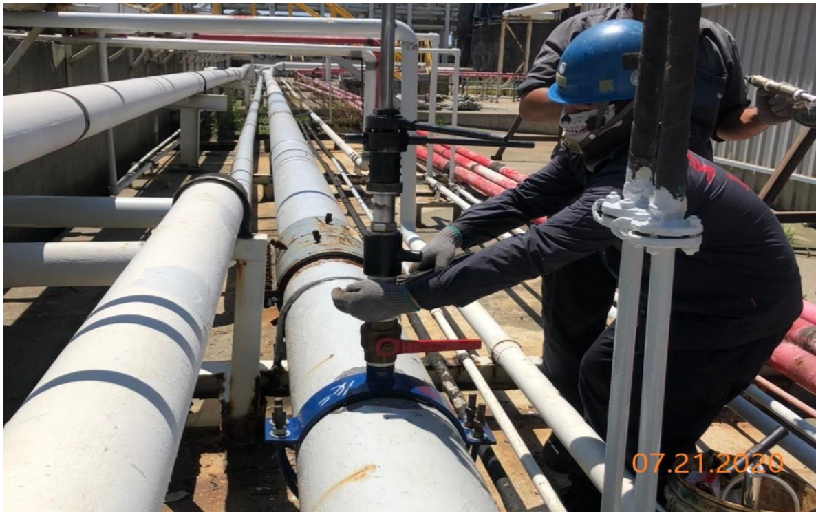
14" 管線線上插管作業 2" hot tapping (8)
