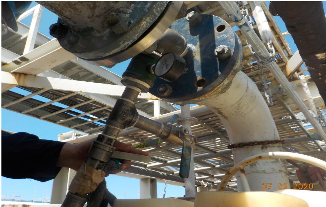
發射端安裝情況(3)
