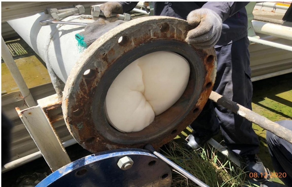
安裝 14” 海綿 PIG 之情形(11)
