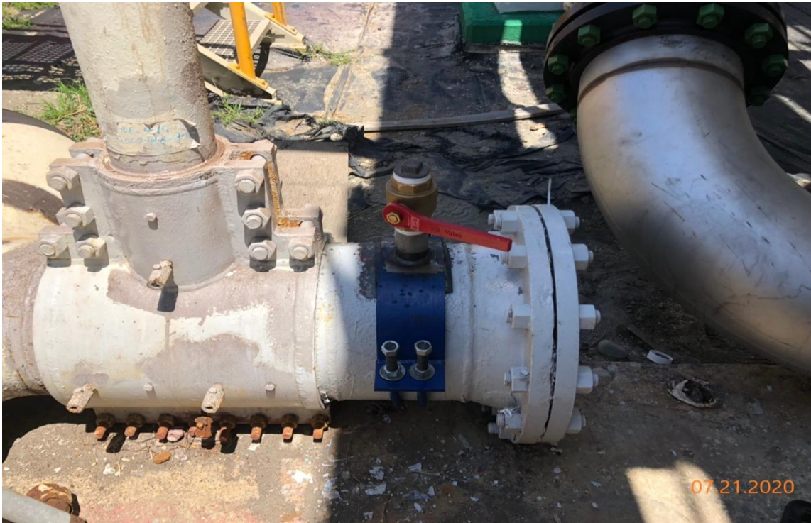
14" 管線線上插管作業 2" hot tapping (9)
